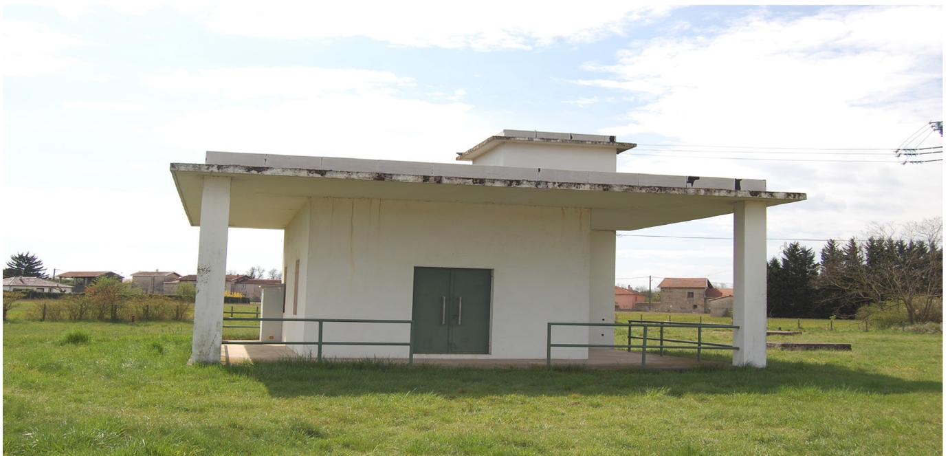
*Captage des Teppes à ST Rambert d'Albon. Ici est prélevé l'eau dans le milieu naturel. La ressource est pompée par forage dans des nappes souterraines. Afin d'éviter la pollution de ces sources, des périmètres de protection sont installés.*
